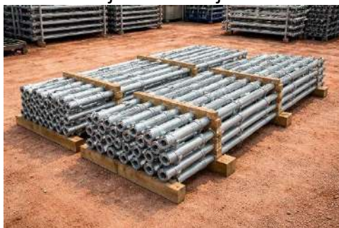
Materiālu krautne nostiprināta pret to nejaušu izkustēšanos
