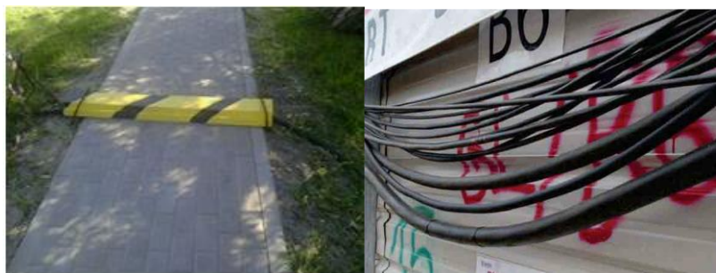
Pārvietošanās ceļos nosegti vai augstumā izvietoti kabeļi
